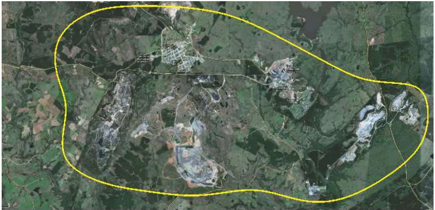
Foto de satélite da área do município de Candiota/RS onde esta instalada a mineração de carvão.
