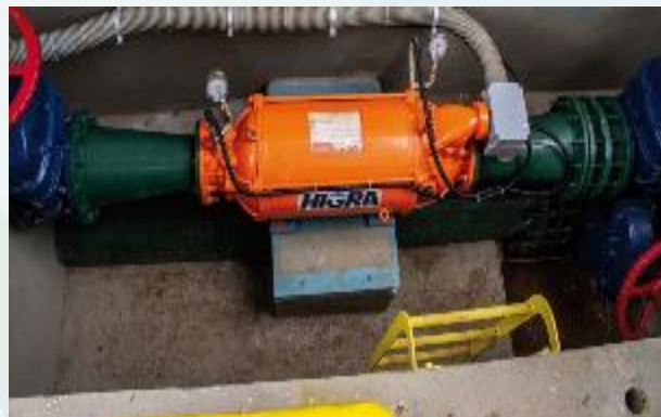
Turbo gerador no reservatório Mussolini (20 mil kWh ao mês)
