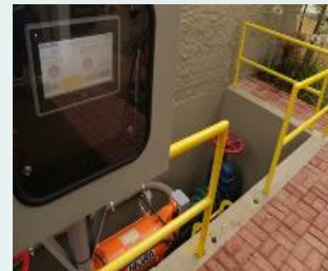
Turbo gerador no reservatório Mussolini (20 mil kWh ao mês)
