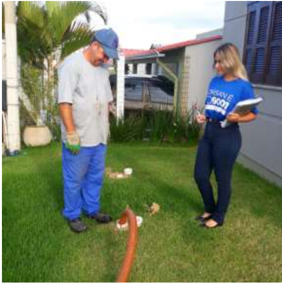
Acompanhamento das Limpezas de Fossas sépticas
