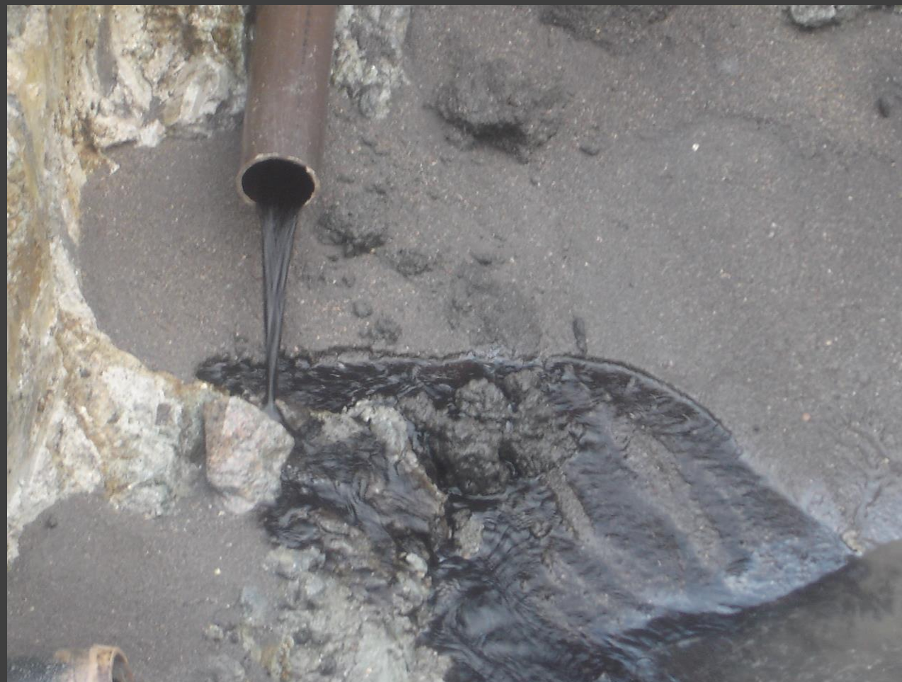
Manganês depositado em Rede de Abastecimento de Água
