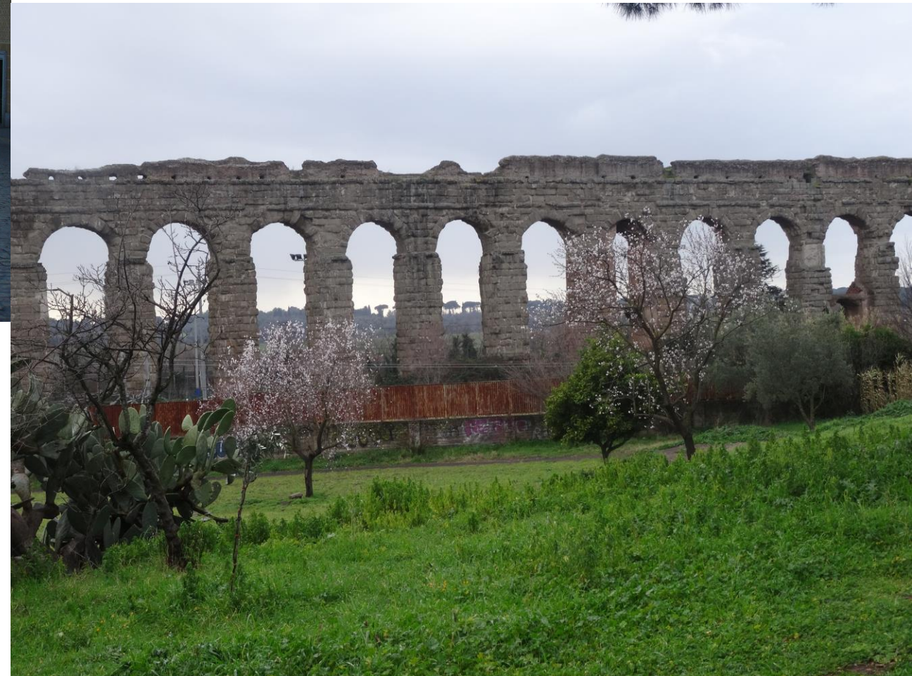
Parque dos Aquedutos, Roma
