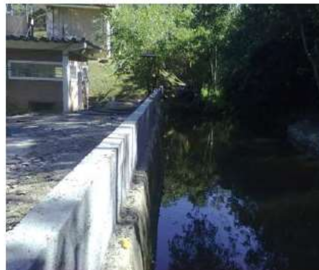
Foto 2 – Depois: Confecção de muretas na lateral da Barragem da captação, para evitar transbordamento
