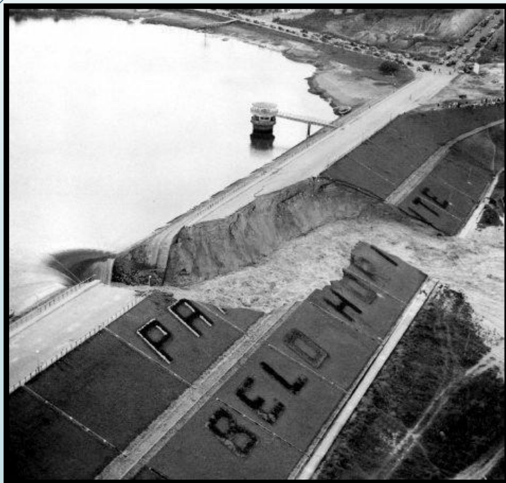
Figura 4 – Rompimento da barragem
