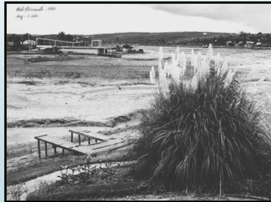
Figura 5 – Lagoa vazia com vista para o late Clube
