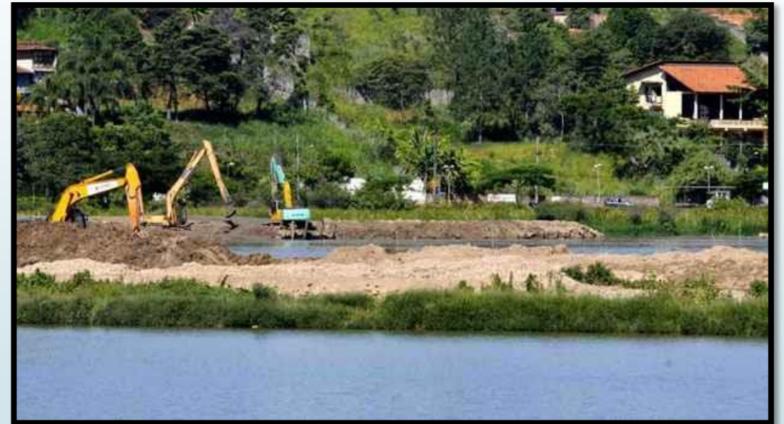
Figura 14 – Equipamentos trabalhando no estoque temporário de sedimentos
