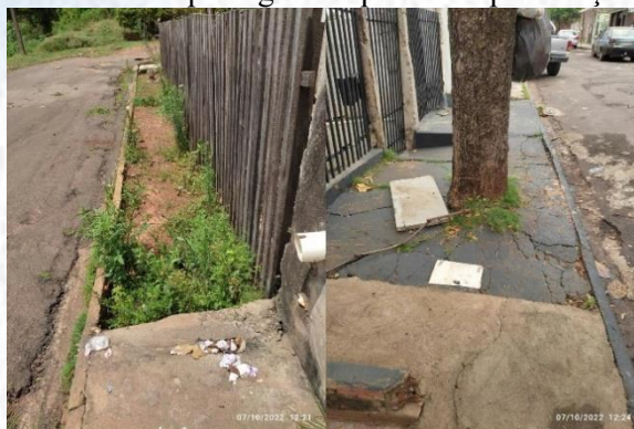
Figura 6 - Conflitos observados no bairro Jardim Bela Vista: Calçada estreita não pavimentada e árvore dificultando passagem de pedestres pela calçada.
