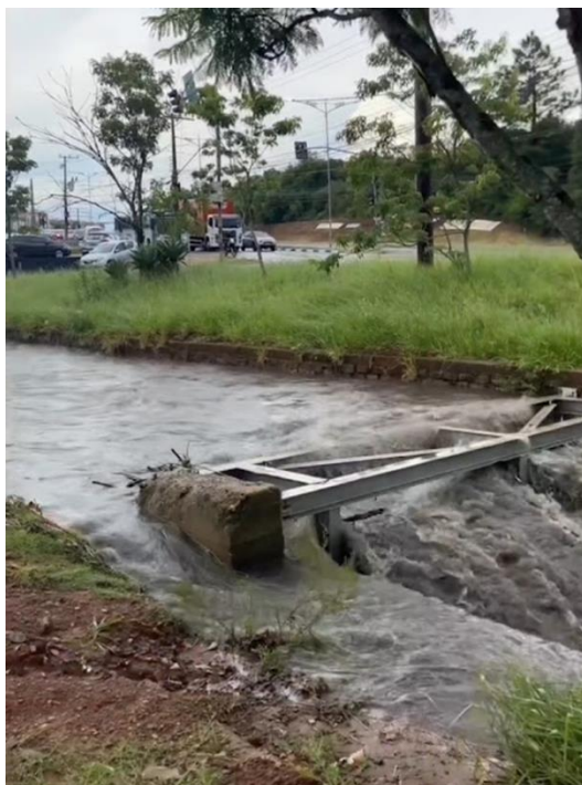
Figura 4 – Eco-barreira no arroio Passinhos transbordando devido às chuvas.
