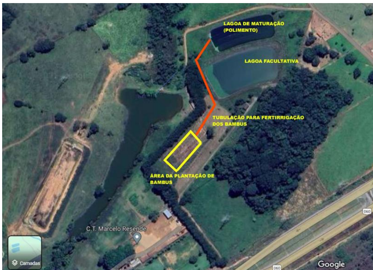
Figura 1 – ETE Abadia de Goiás com área do projeto com bambuzal e lagoas de tratamento
